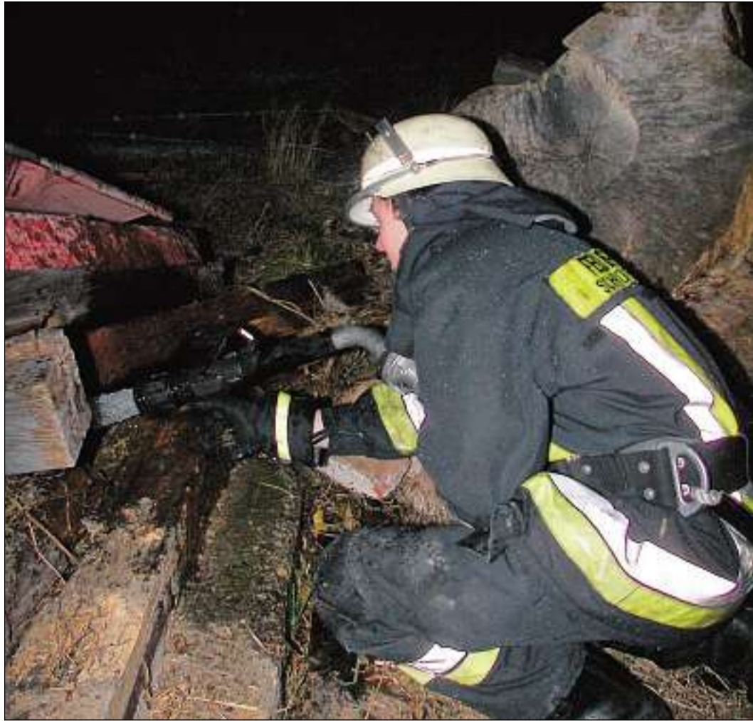
Großalarm wurde für die Feuerwehren Brunnen, Hohenried, Berg im Gau, Edelshausen, Waidhofen und Schrobenhausen am Donnerstag kurz nach 6 Uhr ausgelöst. Ursache war eine am Vortrag abgerissene Lagerhalle in Niederarnbach. Vermutlich lösten Flexarbeiten den vermeintlichen Großbrand aus. Das Feuer, das sich als Kleinbrand entpuppte, wurde rasch unter Kontrolle gebracht. Foto: kfa
